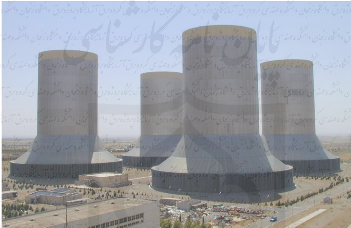
شکل ۱- نیروگاه حرارتی شهید رجایی
